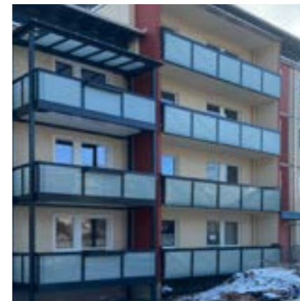
Balkone mit neuen Brüstungen
