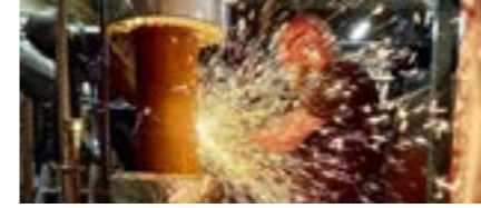
Umbindungsarbeiten an den Fernwärmeleitungen
