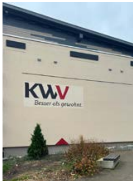
Neue Holzkonstruktion mit geneigtem Dach
