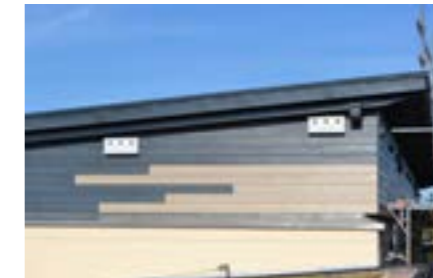
Nistkästen an der neuen Holzkonstruktion
