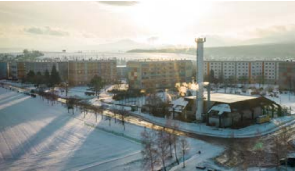
Hier entsteht die WVO Fernwärme: Heizkraftanlage Olbersdorf
