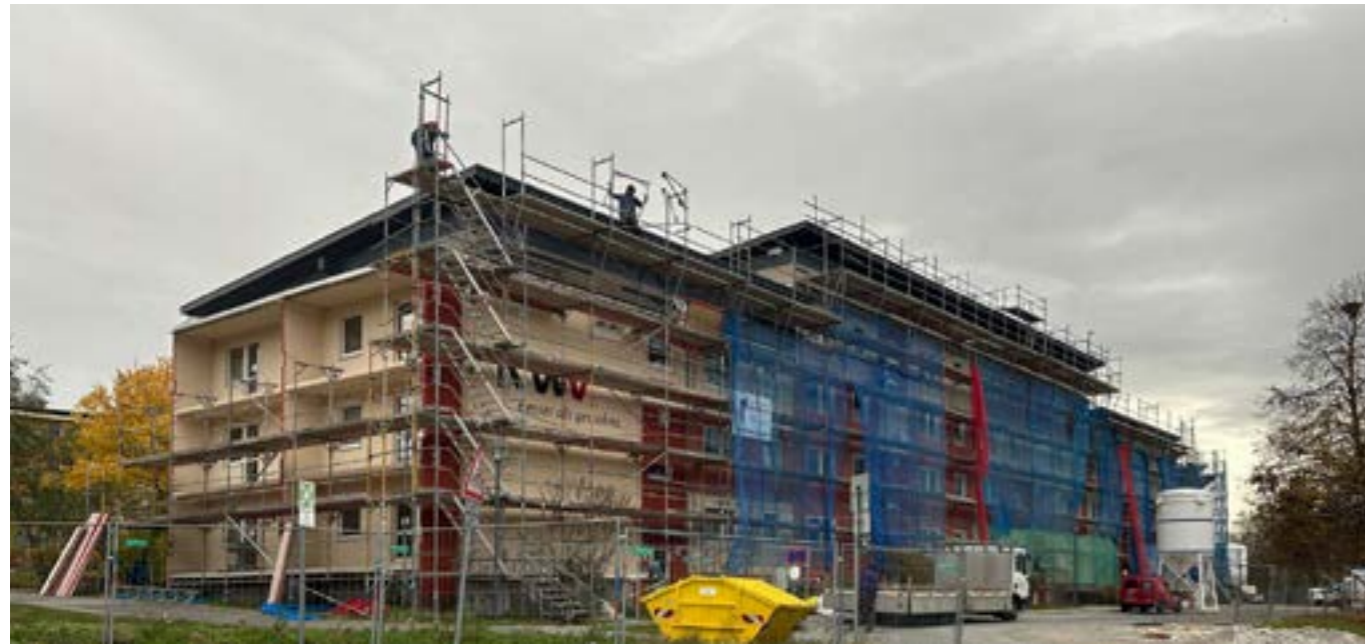
Hinter dem Gerüst ist die moderne Fassade schon zu erkennen
