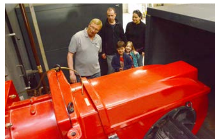
Herr Grohmann führte durchs Heizwerk
